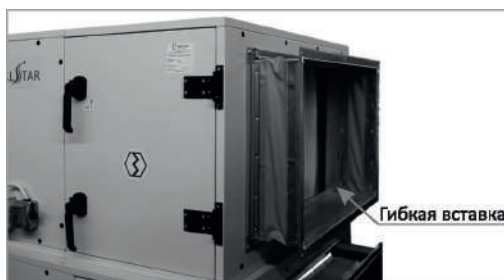
Подсоединение воздуховодов (рис. 13)
